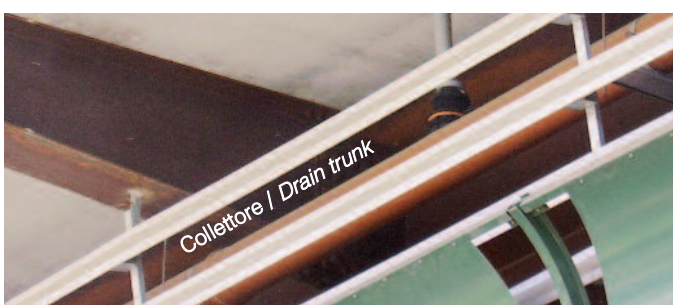
Vista degli allacciamenti eseguiti con Easy Clip / View of the connections performed using the Easy Clip
