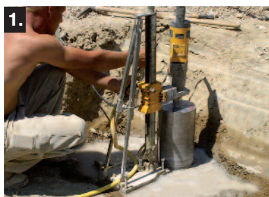
1) Esecuzione della foratura su un tubo Ø800 di calcestruzzo. Drill the hole in the Ø800 concrete pipe.
