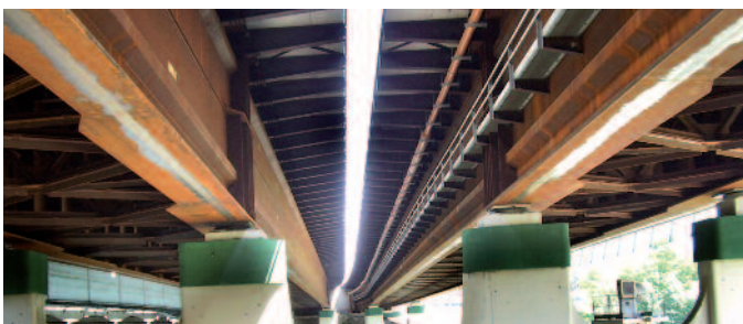
Vista del ponte da sotto / View of the bridge from below
