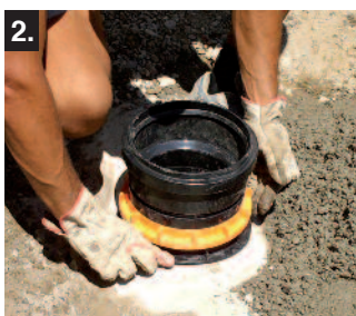
2) Inserimento di Easy Clip Insert the Easy Clip device
