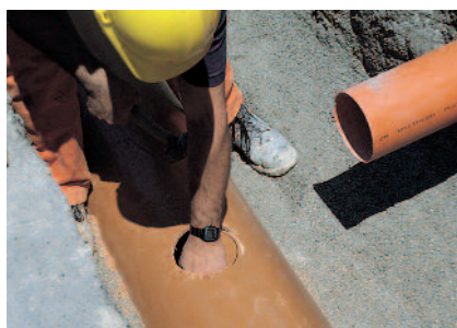
1) Esecuzione della foratura su un tubo Ø315 in PVC Drill the hole in the Ø315 PVC pipe
