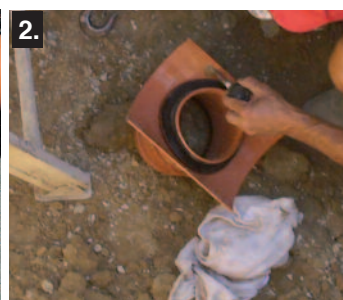
2) Inserimento e serraggio di Easy Clip City con la chiave in dotazione. Insert and tighten the Easy Clip City using the supplied tool.
