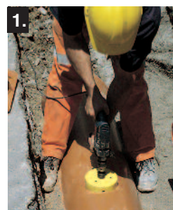
1) Esecuzione della foratura su un tubo Ø315 in PVC Drill the hole in the Ø315 PVC pipe
