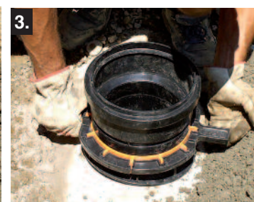
3) Serraggio della clip Tighten Easy Clip twisting on the nut
