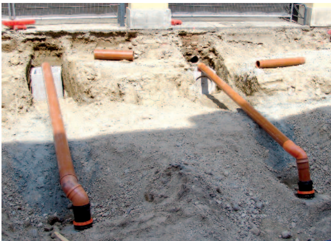
Easy Clip è stato utilizzato nella realizzazione degli impianti di scarico grandi diametri della banchina stradale. Easy Clip have been successfully installed for conveying surface waters from highway bridges
