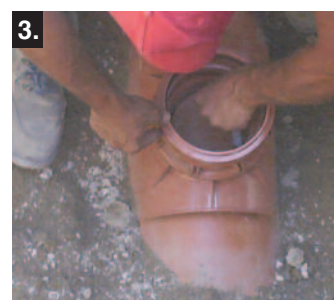
2) Inserimento e serraggio di Easy Clip City con la chiave in dotazione. Insert and tighten the Easy Clip City using the supplied tool.
