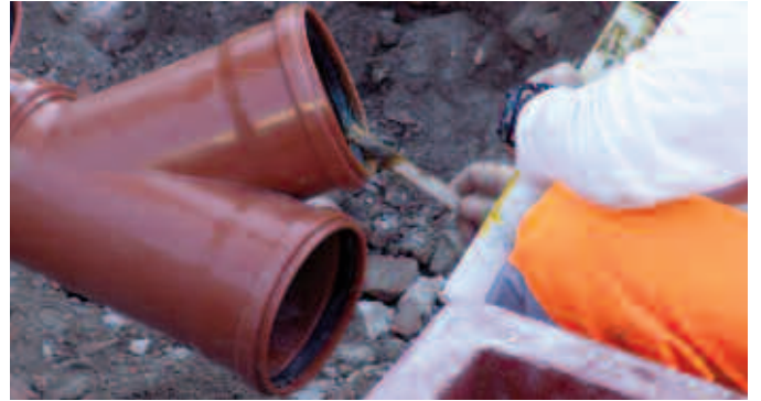
Lubrificazione della guarnizione / Seal lubrication
