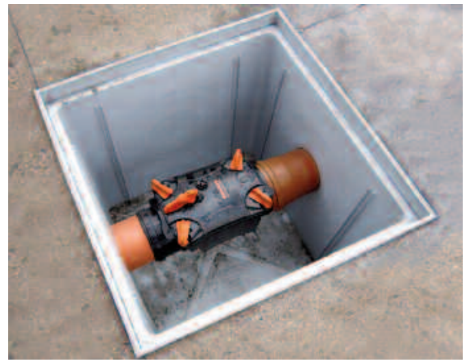
Valvola antiriflusso Ottima installata in pozzetto di ispezione Ottima NVR inside an inspection chamber
