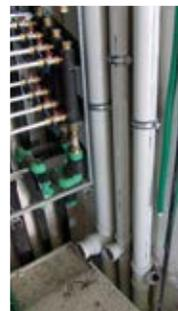
Colonne di scarico di acque nere e grigie separate realizzate con il sistema fonoassorbente Phonoline.
