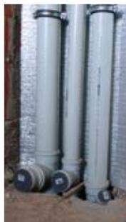
Colonna scarico acque nere realizzate con Phonoline Ø110. Scarico acque grigie Phonoline Ø 90 e Ø 75. Sono stati utilizzati collari antivibranti, e guaina disaccoppiante per garantire alte prestazioni fonoassorbenti.
